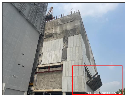
ภาพที่ 30 Chain Link ป้องกันวัสดุตกหล่น
