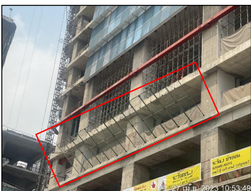
ภาพที่ 30 Chain Link ป้องกันวัสดุตกหล่น
