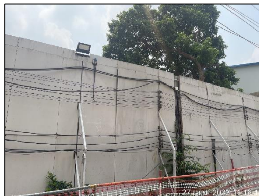
ภาพที่ 47 กำแพงกันเสียงชนิด Bloxteg 2 Tuff Series
