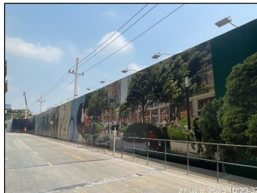
ภาพที่ 1 รั้ว Metal Sheet สูง 6 เมตร รอบพื้นที่โครงการ
