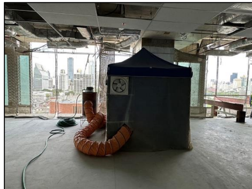
ภาพที่ 19 พัดลมดูดฝุ่นบริเวณที่มีกิจกรรมที่เกิดฝุ่นละออง
