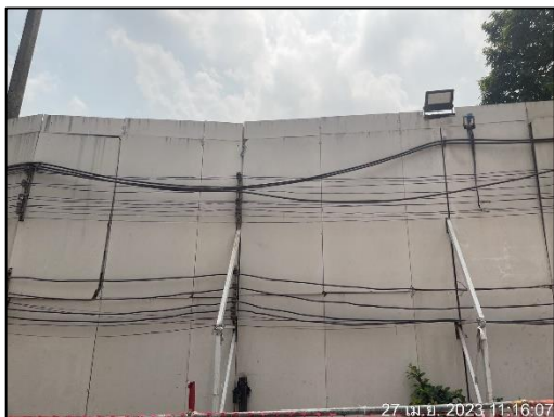
ภาพที่ 47 กำแพงกันเสียงชนิด Bloxteg 2 Tuff Series
