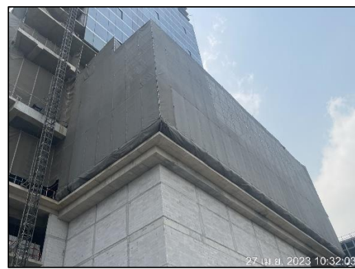
ภาพที่ 56 ผ้าใบกันฝุ่น (Mesh Sheet)
